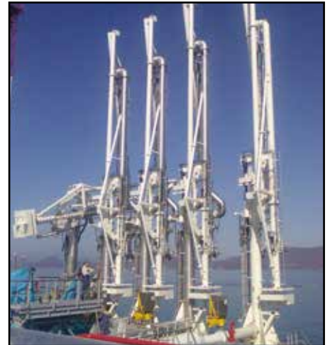
LNG & condensate marine loading arms
